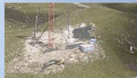
Baustelle bei Stütze 1 (17. Juli 2013)
