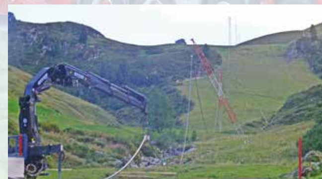
Seilzug auf Hilfsstützen von der Gampenhahntalstation.
