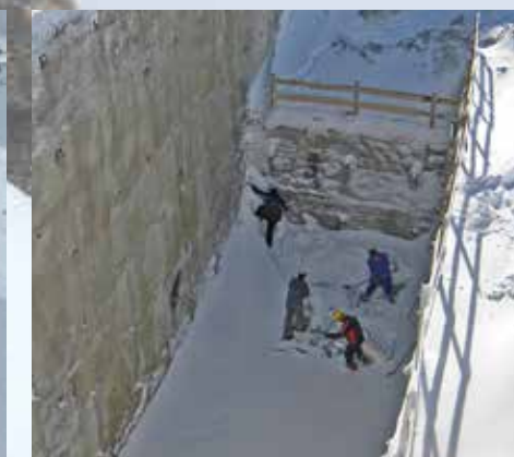
Der Zugseilspannschacht muss wieder ausgeräumt werden.
