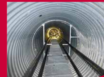
Tunnel mit den 4 Rückspanankerseilen
