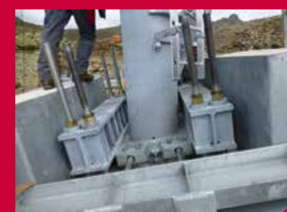
Konstruktion für die Querverschiebung der Stütze Nr. 5
