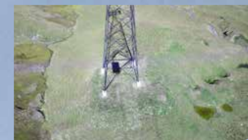
Umgebung der Stütze 1 nach den Begrünungsmaßnahmen (2. August 2014)
