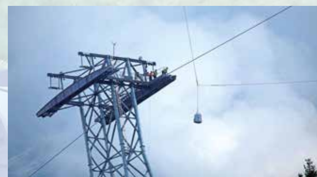
Der (hier nicht im Bild sichtbare) Hubschrauber mit dem Spezialseil für den Zug des 2. Tragseiles bei der Pardatschgratbahn.
