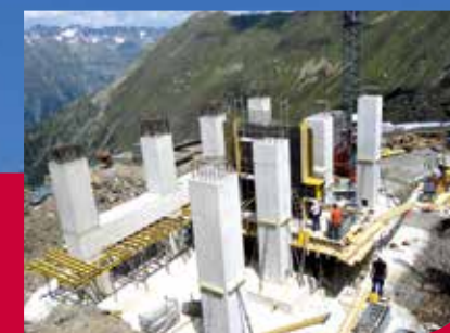
Stützfundamente für die Bergstation
