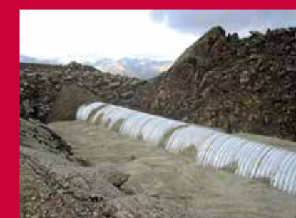
Tunnel vor Zuschüttung
