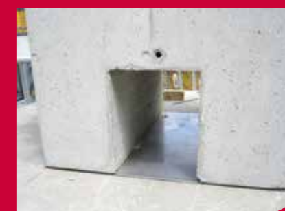
Einzelfundament, aufgesetzt auf Stahlplatte
