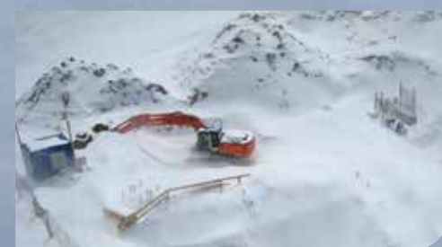
Schwierigste Bedingungen beim Stützenbau.
