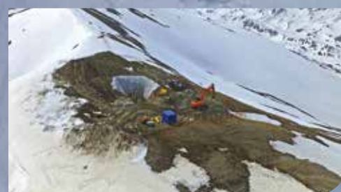
Erste Grabungen bei Stütze 2.
