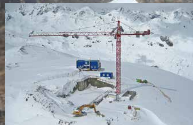
Die schneebedeckte Baugrube beim morgendlichen Anflug.
